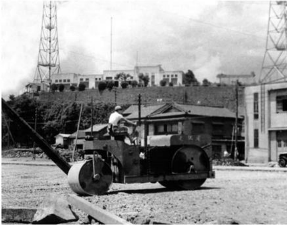
駅前広場の舗装工事
