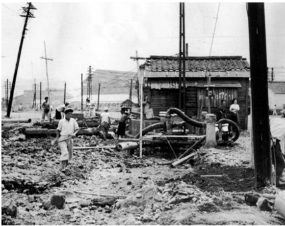
道路改良工事における埋戻作業
