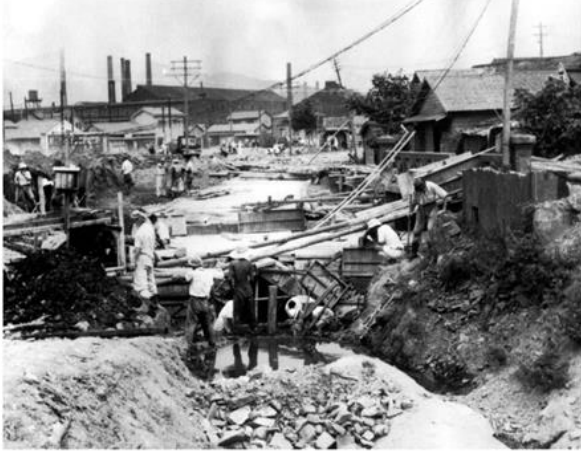
道路改良工事の風景
